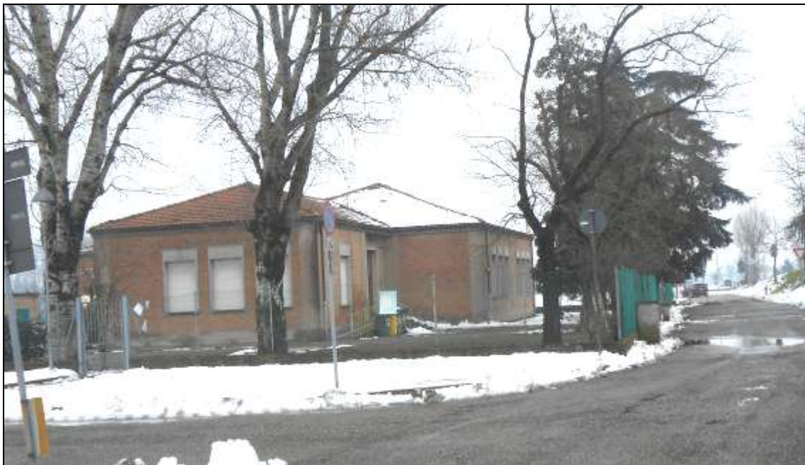
FOTO 01_foto lato Ovest, scatto da parcheggio pubblico.
