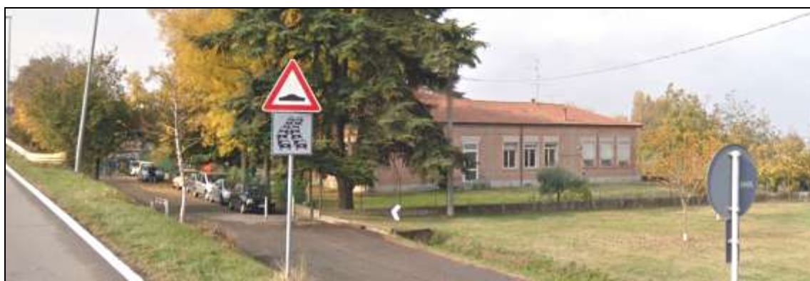
FOTO 03_foto lato Est, scatto da via Matteotti.
