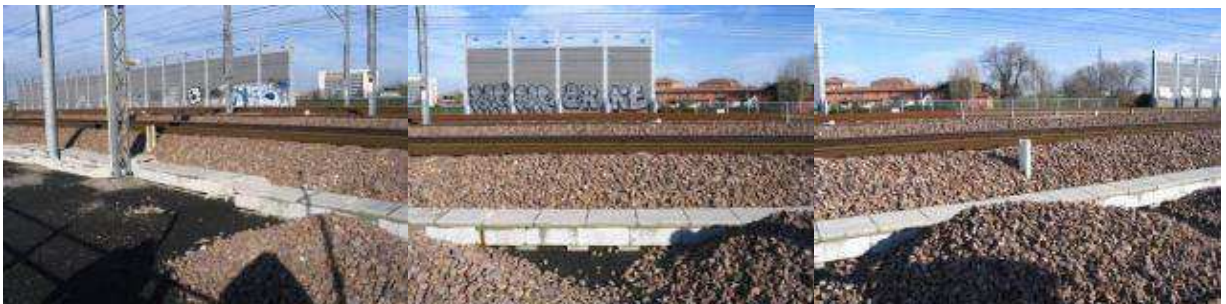
Figura 3 - Fotografie delle barriere antirumore nei pressi della linea ferroviaria Bo-Mi
