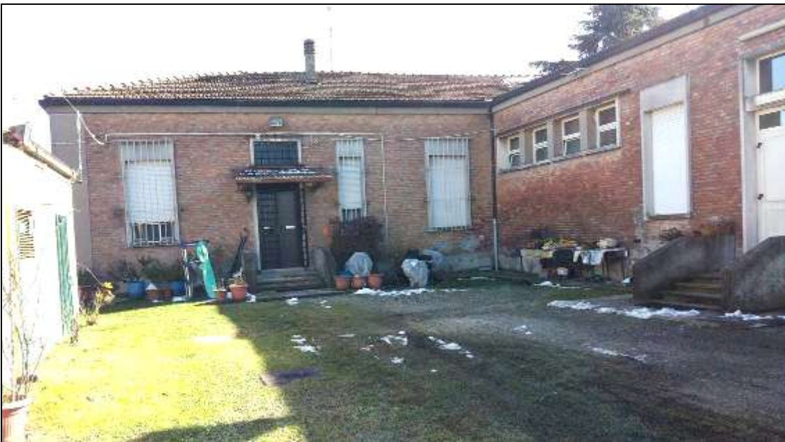
FOTO 02_foto cortile interno (lato Ovest), si nota l'accesso della residenza del custode.
