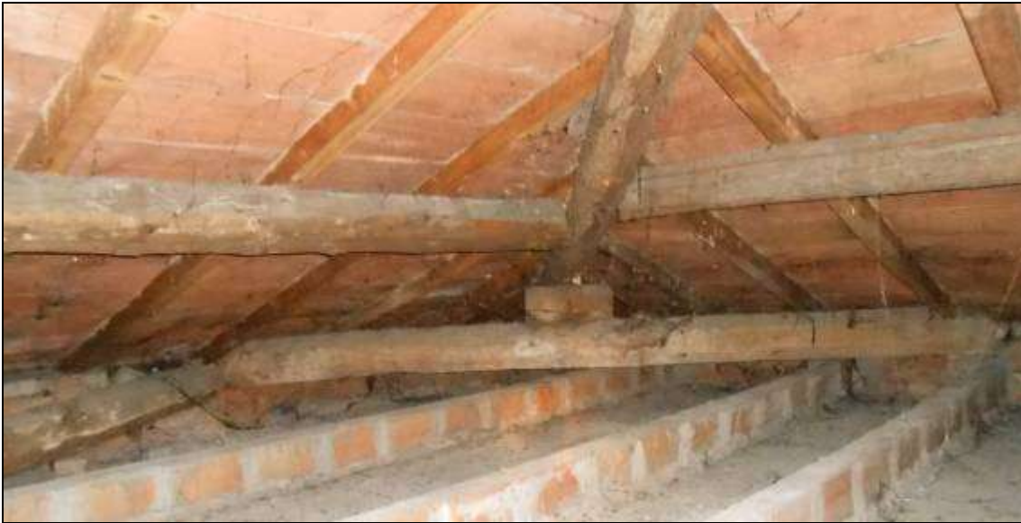
FOTO 04_foto sottotetto,parciolare del cantonale.
