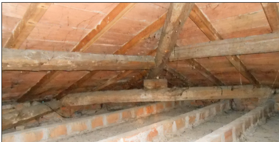
IMM07_foto sottotetto: particolare del cantonale.
