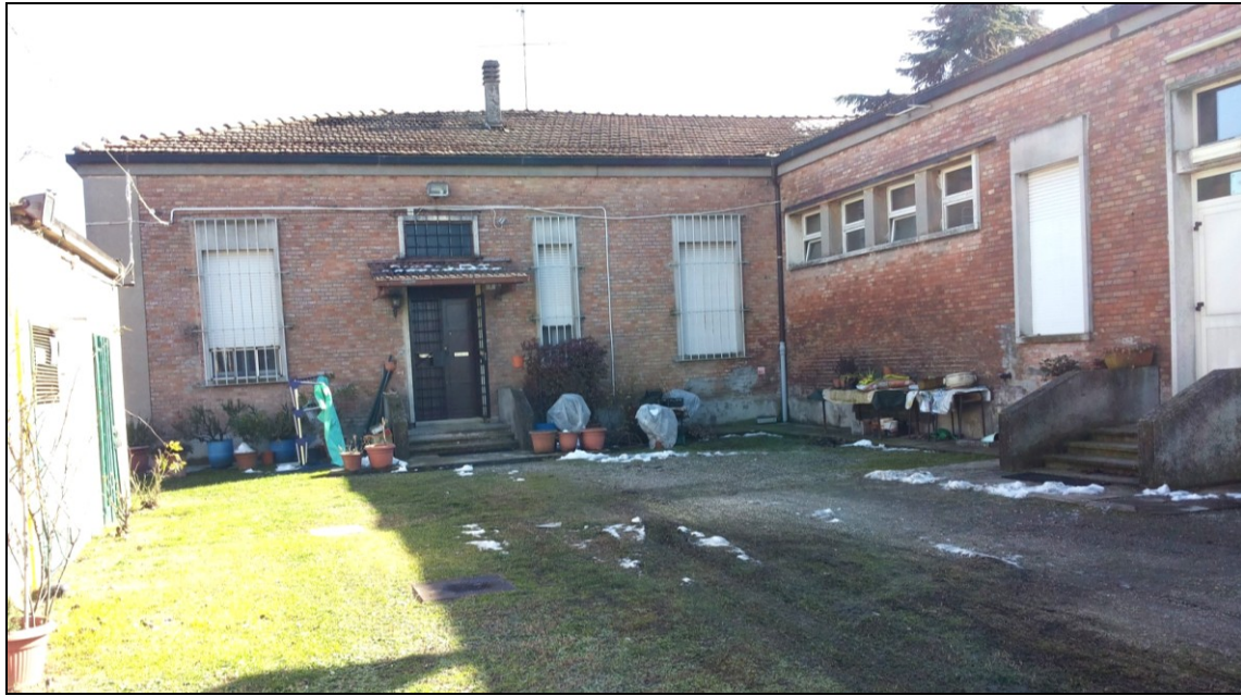
IMM05_foto cortile interno (lato Ovest), si nota l'accesso della residenza del custode.
