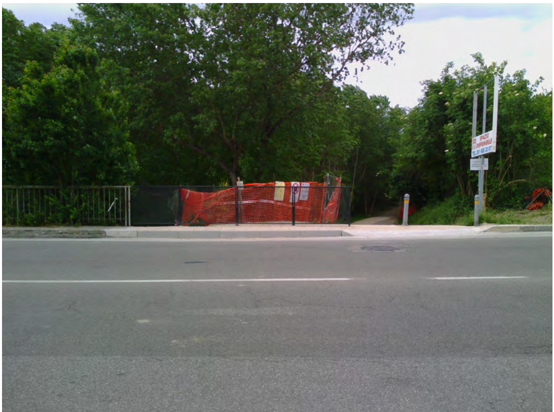
Gli accessi al percorso lungo Navile, come si presentavano prima dell'inizio del cantiere in Via di Vittorio, Castel Maggiore e verso la fine dei lavori del primo stralcio. Si nota, anche in corrispondenza di questi punti, l'assenza di apparati segnaletici che dichiarino la presenza del canale, così come la mancanza di un attraversamento pedonale protetto.
