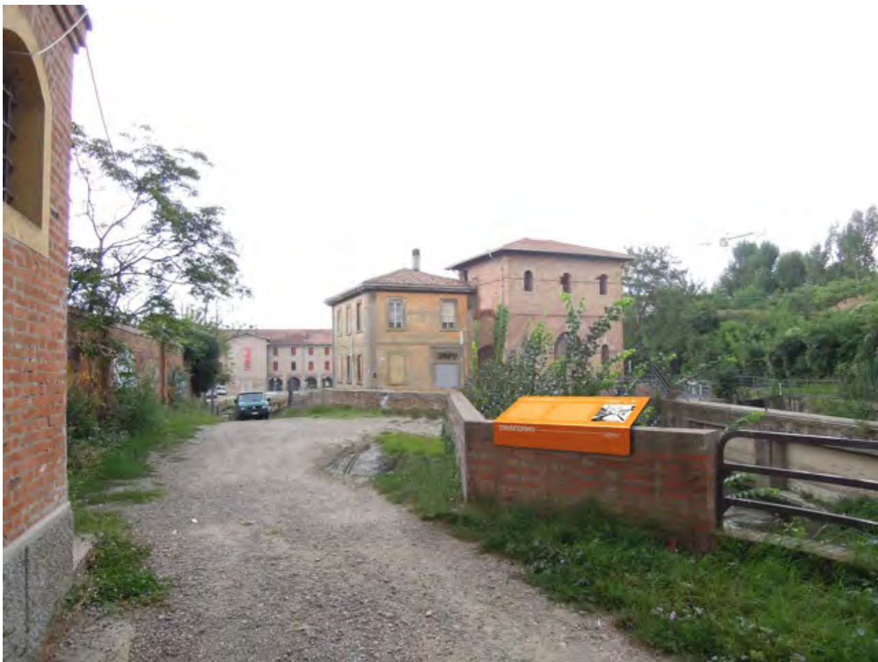
Esempio di leggìo illustrativo da posizionare in diversi punti del percorso, integrandolo ai manufatti esistenti. In questo fotoinserimento si vede la collocazione al sostegno del battiferro, comune di Bologna.
