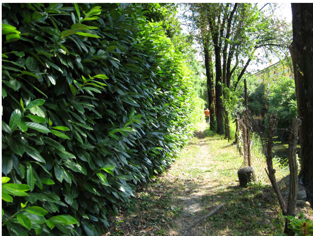
Il sentiero nel tratto in cui costeggia la conca di navigazione del sostegno di Castello. Sullo sfondo il ponte sul canale. In basso il percorso poco prima di arrivare a Castello. Si nota l'assenza di apparati segnaletici indicanti la presenza del canale.
