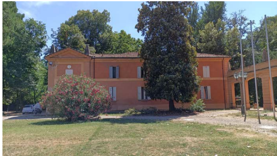
Foto 12: corpo meridionale del complesso, fronte nord
