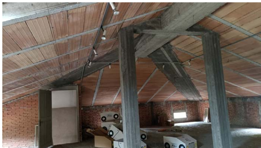
Foto 32: corpo centrale, locale sottotetto
