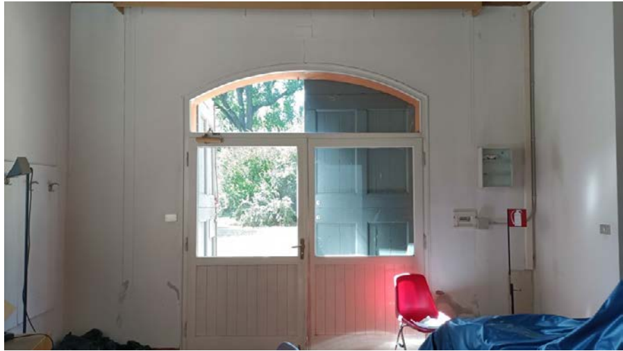
Foto 33: corpo settentrionale, ingresso
