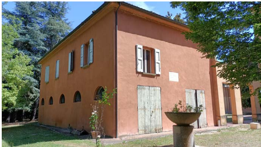
Foto 7: corpo settentrionale del complesso, fronte ovest
