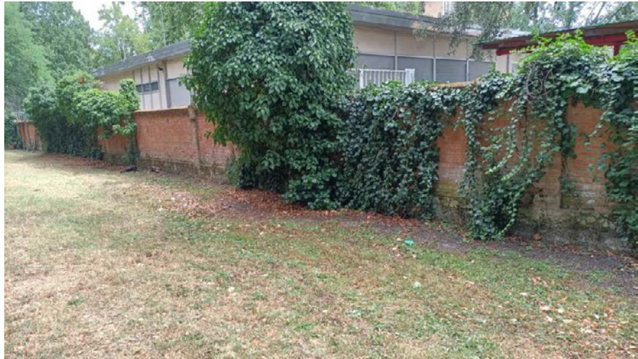
Foto 19: muro di confine sul lato sud
