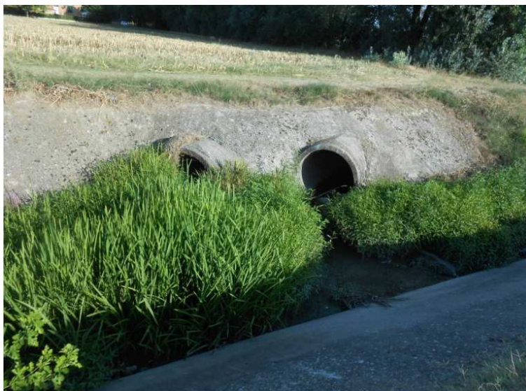
Foto 7 Scarichi sullo Scolo Bondanello
