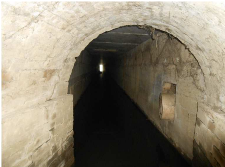
Foto 4 Ponte Via Lirone vista interna
