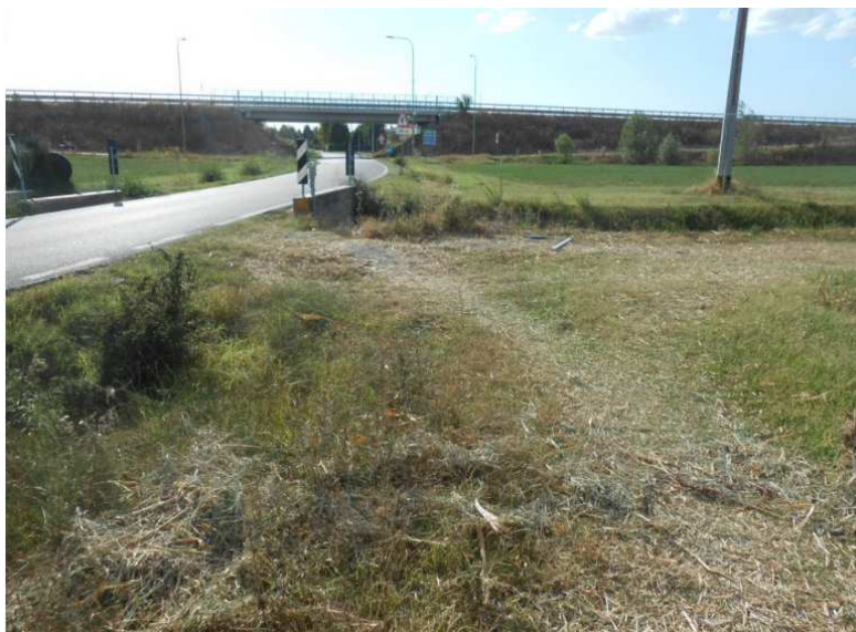
Foto 2 Ponte Via Lirone
