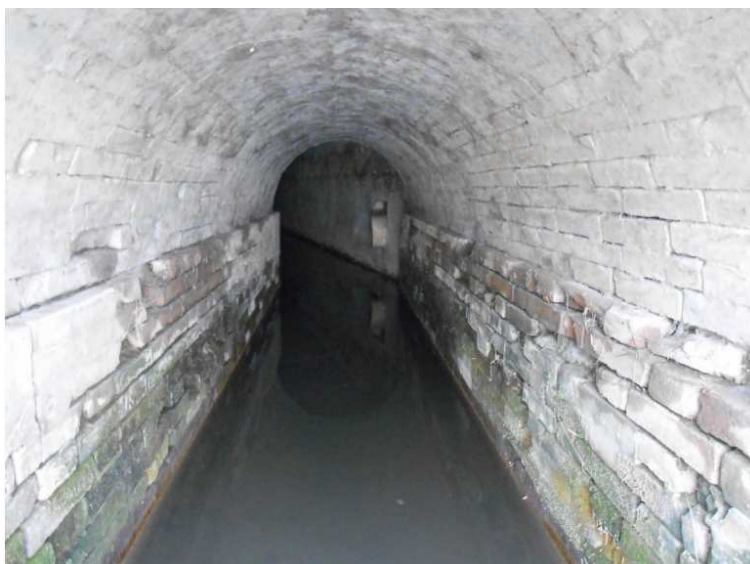
Foto 3 Ponte Via Lirone vista interna
